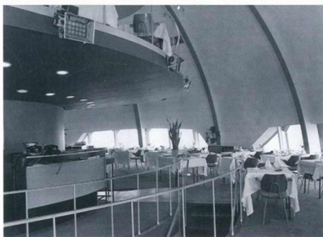
Lors de l'Exposition universelle en 1958, Infragaz a assuré l'installation du chauffage dans les zones d'accès et dans le célèbre restaurant panoramique de l'Atomium (Collection Goblet).
