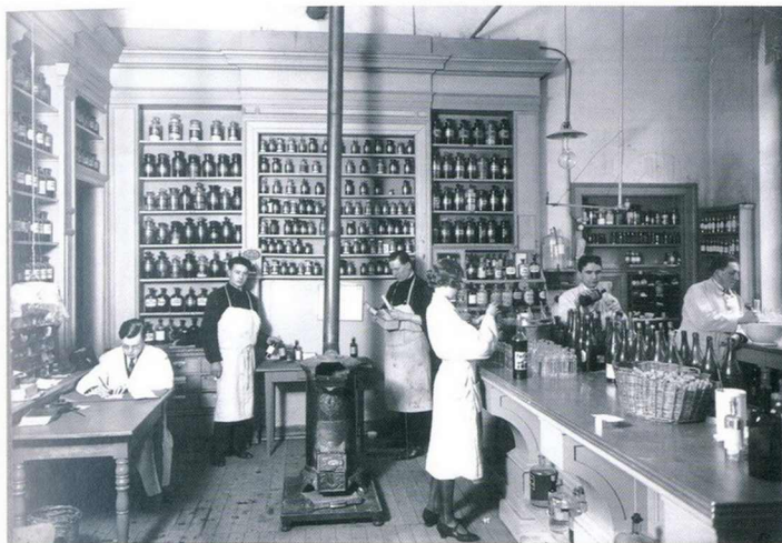
Dans les lieux publics, le poêle trône au milieu de la pièce. Il est relié à la cheminée par une buse qui diffuse elle aussi de la chaleur; ici l'officine de l'hôpital Saint-Jean vers 1900 et une classe de lecture d'une école primaire bruxelloise vers 1930 (AVB et IRPA).
