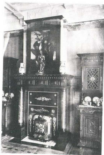
Poêle en fonte encastré dans la cheminée, avec portillon équipé de vitrages translucides. Il est comparable à la Salamandre. Ce type d'appareil convenait bien aux salles à manger étroites et encombrées. Intérieur d'une habitation avenue Louis Bertrand à Schaerbeek. Extraite de Vers l'Art , 1907, pl. 13 (BR).
