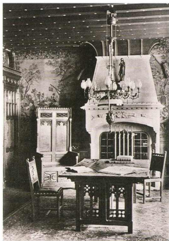
Ce grand radiateur placé sous l'arc d'une cheminée de salle à manger "à la flamande" illustre les collisions temporelles – involontairement cocasses – dont témoignaient de nombreux intérieurs éclectiques. Salle à manger de une habitation rue Renkin à Schaerbeek. Extrait de Vers l'Art , 1906, pl. 5 (BR).
